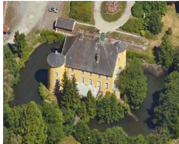
Schrägluftbild- Aufnahmeerichtung Nord
