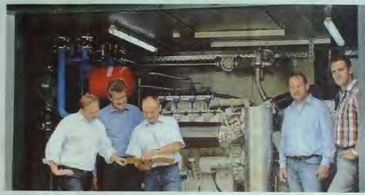
Blick ins Blockheizkraftwerk (von links): Landrat Dr. Kai Zwicker, Schulleiter Josef Brinkhaus, Norbert Seyer vom Kreis, Klemens Klümper und Michael Kapell vom Investor. Foto: Andriens
