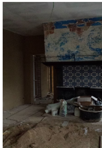
Bild: Ausbauzustand „Armenhaus“ am 14. Dez. 2017; Lehmputzarbeiten
